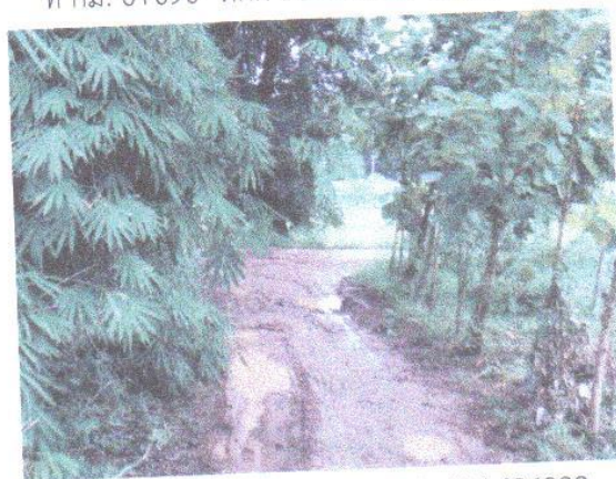
ที่ กม. 0+185 พิกัด 16.607182, 104.496822
